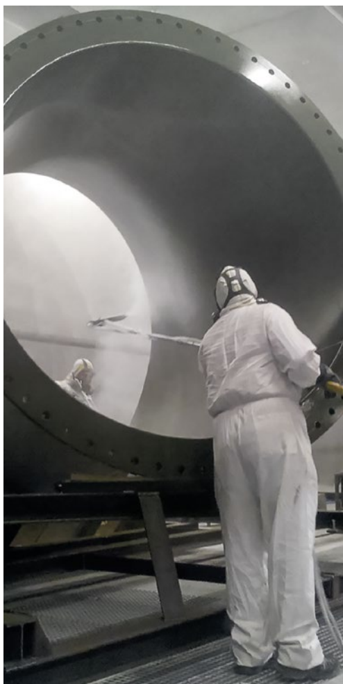
Påføring af korrosionsbeskyttende Accoshield belægning
