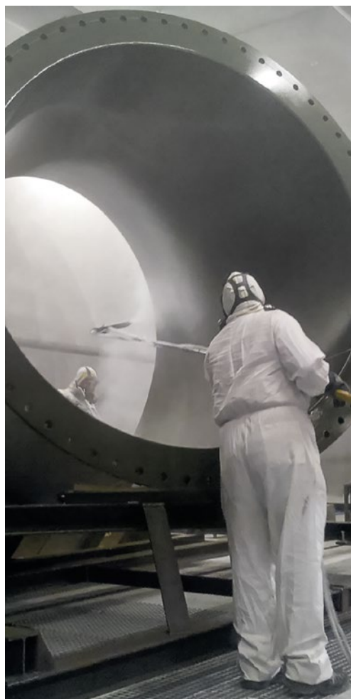
Påføring af korrosionsbeskyttende Accoshield belægning
